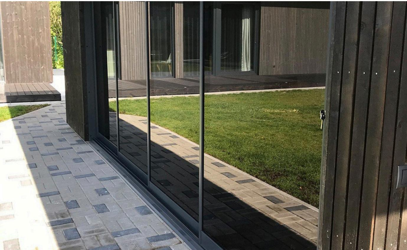
Vidrio con anchuras máximas de 1500 mm y altura máxima del sistema de 2600mm
